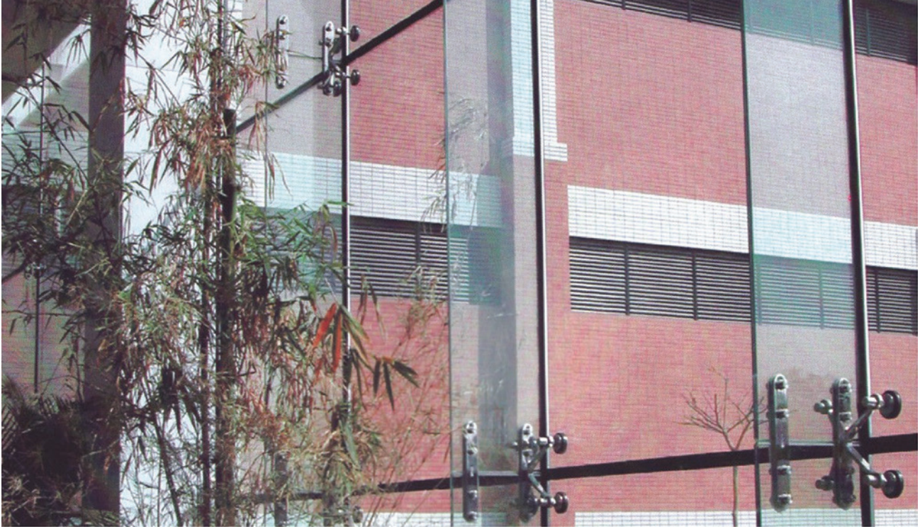
Spider Bağlantı SF-F250-4 Spider Fitting For Glass
