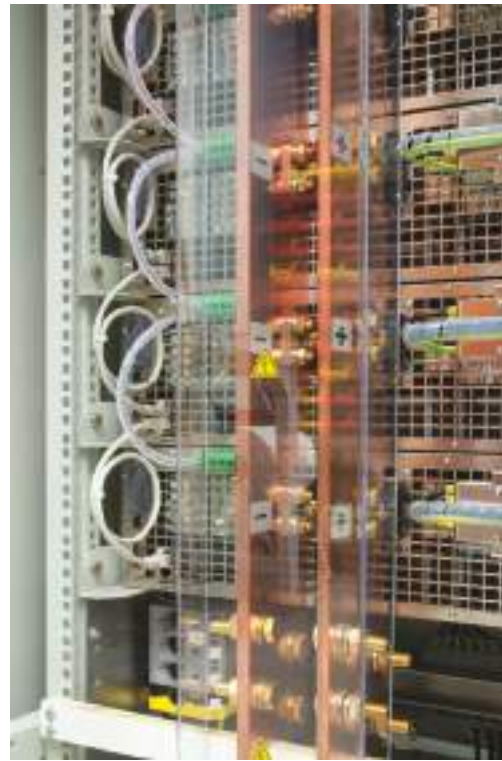
DC-Anschluß / DC bus terminal
