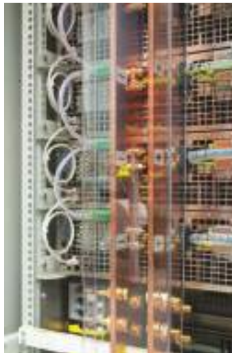
DC-Anschluß / DC bus terminal
