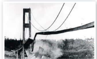
Tacoma köprüsünün yıkılış anı
