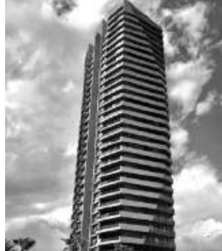
Saray İnşaat Gökkule - Mersin
