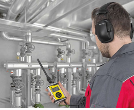
Shotgun ses sondası aracılığıyla, gizlenmiş durumda olmayan hatlardaki kaçakların yeri nokta hassasiyetinde tespit edilebilir.
