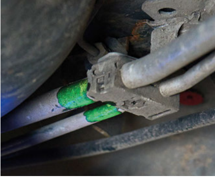
UV ışığı altında kontrast maddesi aracılığıyla bir motorlu taşıt klima sisteminin soğutma gazı hattındaki kaçakları belirleme.
