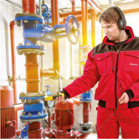
Pompalarda ve diğer iş makinelerinde, gövde ses sondası ile aşınma belirtileri erkenden belirlenebilir.
