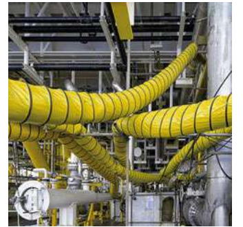
TFV üniteleri, yüksek karşı basınç bulunan uzun sevk hatlarının havalandırılması için optimum düzeyde uygundur.
