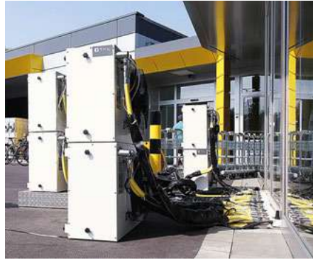
PlanoPT aracılığıyla altından hat geçirilen kapılar kapalı kalabilir, bu sayede geceleri kapatma nedeniyle bağlantıların sökülmesi gerekmez ve klima cihazları gerektiğinde yirmi dört saat çalışır durumda kalabilir.
