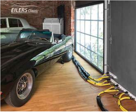
İhtiyaç duyulan bağlantı hatları için klasik döşeme erişiminin olmadığı büyük etkinlik salonları bile PlanoPT kullanımı sayesinde sürekli olarak iklimlendirilebilir.
